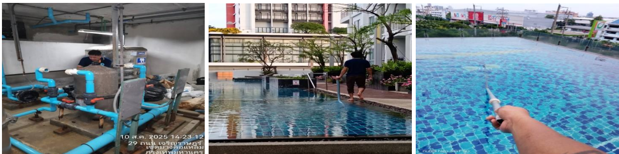
ทำความสะอาด/ดูดตะกอน/ตะไคร่น้ำในสรวายน้ำ
