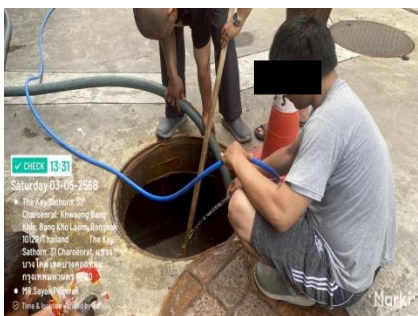
สูบลบเกราะ กากตะกอนส่วนเกินระบบบำบัดน้ำเสีย ประจำปี 2568
