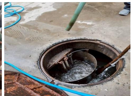
สูบลบเกราะ กากตะกอนส่วนเกินระบบบำบัดน้ำเสีย ประจำปี 2568
