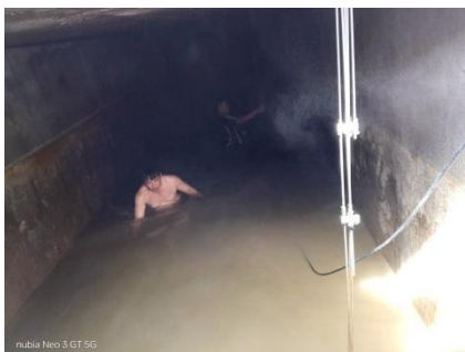
รูปที่ 2.1-9 ล้างถังเก็บน้ำสำรองและตรวจเช็คสภาพถังเก็บน้ำสำรอง ประจำปี 2568 ระบบน้ำใช้โครงการ (ต่อ)
