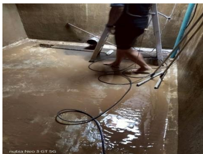
รูปที่ 2.1-9 ล้างถังเก็บน้ำสำรองและตรวจเช็คสภาพถังเก็บน้ำสำรอง ประจำปี 2568 ระบบน้ำใช้โครงการ (ต่อ)
