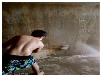
รูปที่ 2.1-9 ล้างถังเก็บน้ำสำรองและตรวจเช็คสภาพถังเก็บน้ำสำรอง ประจำปี 2568 ระบบน้ำใช้โครงการ (ต่อ)
